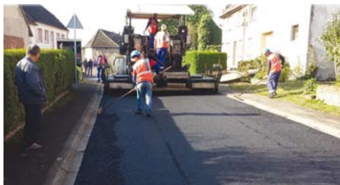
Enrobés Rue Montchaude - Octobre 2016
