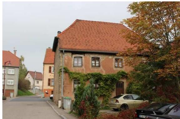
Les constructions anciennes se présentent comme un corps de bâtiment unique, de volume simple, s'élevant au maximum, **sur deux niveaux d'habitation, (R+I+comble)**. La maison est surmontée **d'une toiture à deux pans** voire quatre pans pour les bâtiments en extrémité de rue, **au faitage parallèle à la rue. Les toitures sont majoritairement en tuile rouge.**
